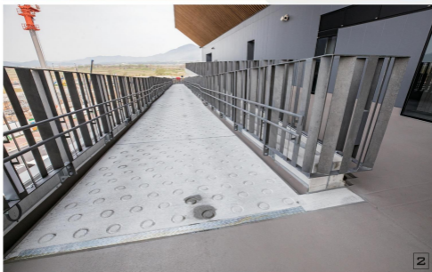
1 2 スチール手摺 ( 溶融亜鉛メッキ + リン酸処理 ) Steel Handrail ( Hot dip galvanizing + Phosphating )
